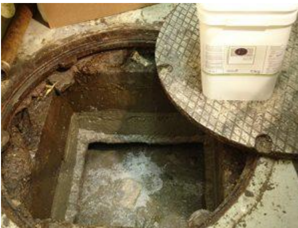
Imagen 1: se agregó BCP10 antes de liberar los desechos a la planta de tratamiento. Los niveles de DQO cayeron al nivel más bajo que había estado en la historia de la planta.
