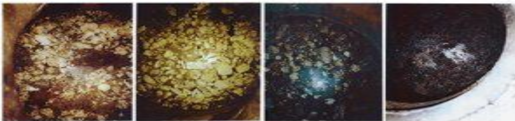
Imagen 3: El efecto progresivo de la bioaumentación en acumulación de FOG en una trampa de grasa.
